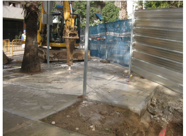
FOTO 2. Vista general del carrer abans d'iniciar els treballs d'obertura de la rasa
