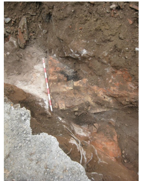
FOTO 4. Mur de fonamentació UE 01 de l'antiga fàbrica de la Maquinista Marítima i Terrestre
