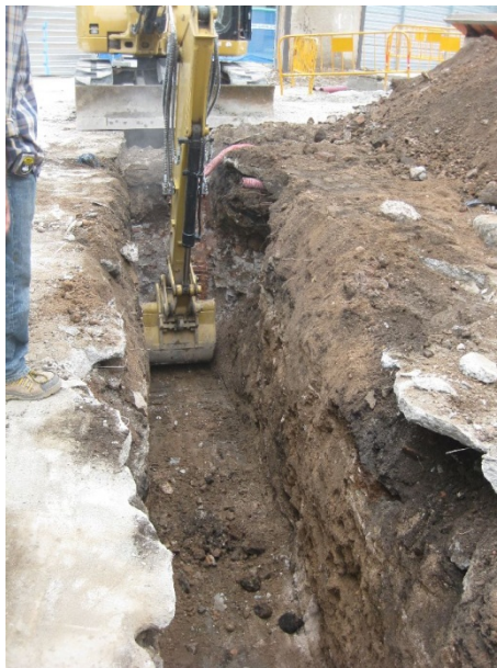
FOTO 3. Treballs mecànics d'obertura de la rasa
