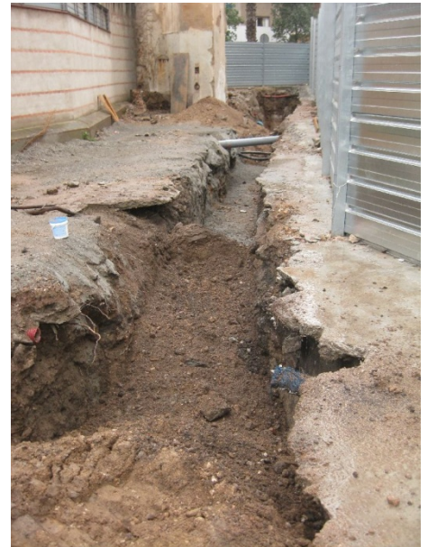
FOTO 12. Vista general dels treballs finalitzats
